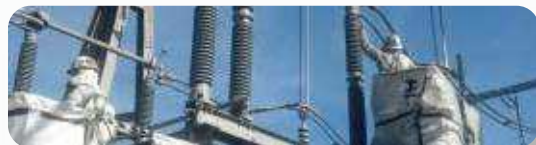
Servicio Aplicación de Revestimiento RTV para Aisladores de MT y AT.
