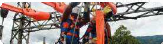
Certificación en Entrenamiento y Reentrenamiento en Líneas Energizadas Hasta 500 KV. (Trabajos Con Tensión)
